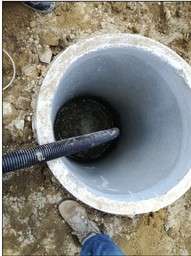
Foto 3. Immissione di acqua nella tubazione
